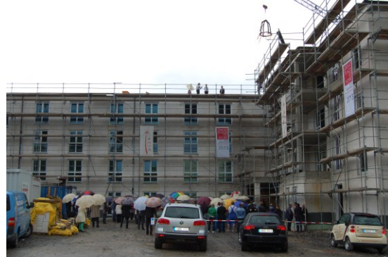
In der Heinrich-Heine-Straße entstehen 108 komfortable Pflegeplätze und 19 Apartments im „Wohnen mit Service“. Eröffnung im September / November.
